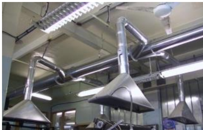
Рисунок 9. Организация местной вытяжной общеобменной вентиляции (по типу «воздушный зонт»)
